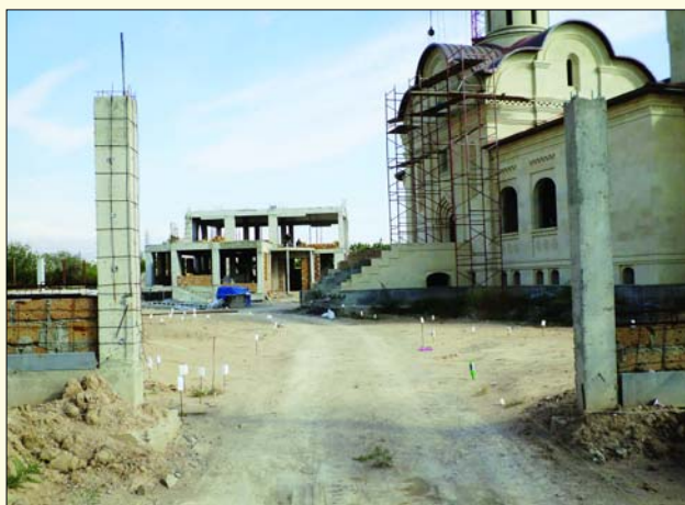
Строительные работы в полном разгаре
